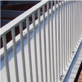
Garde-corps acier galvanisé
